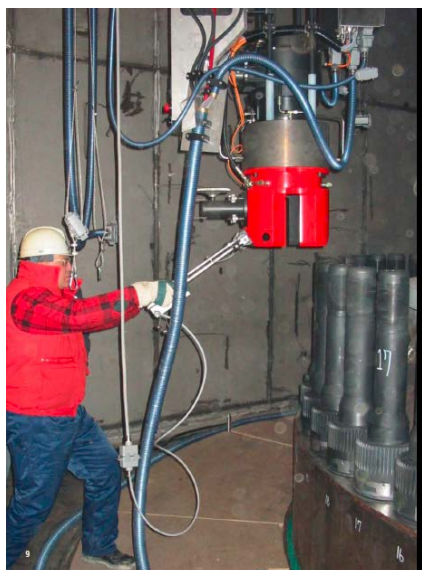
Figure 6 : dévissage des goujons de cuve
